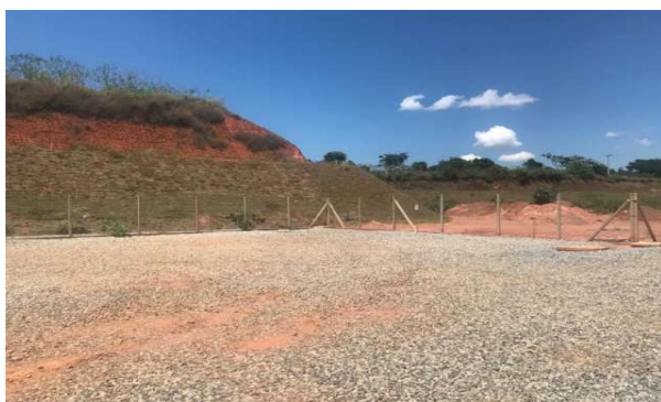
IMAGEM 03 – Estacionamento da Subestação Fernão Dias.
